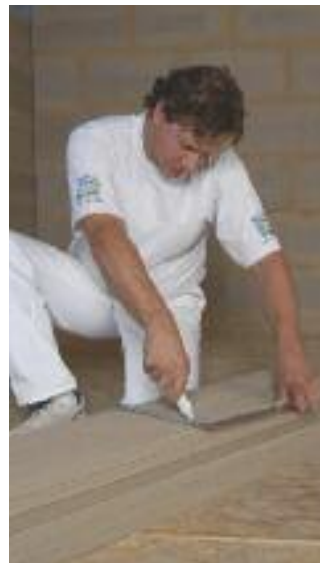
Mit dem Cuttermesser 2 bis 3 mal ritzen
