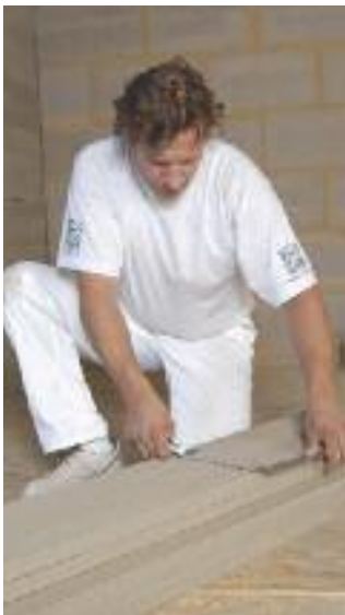
Mit dem Winkel den Schnitt anlegen
