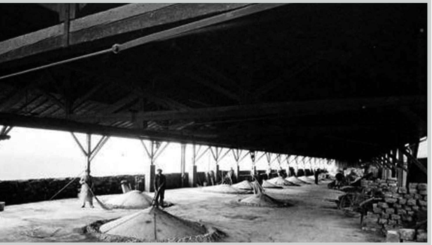
Romanzementöfen um 1900 - oberer Ofenbereich
