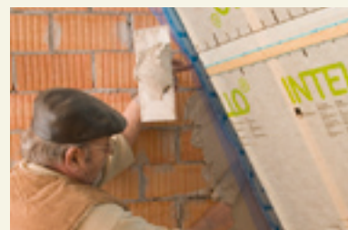
CONTEGA PV Putzanschlussband für definierte, dauerhaft sichere Anschlüsse an zu verputzende Untergründe.
