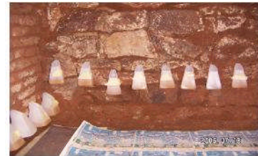
Bild zeigt die Trichtertränkung einer befallenen Wand
